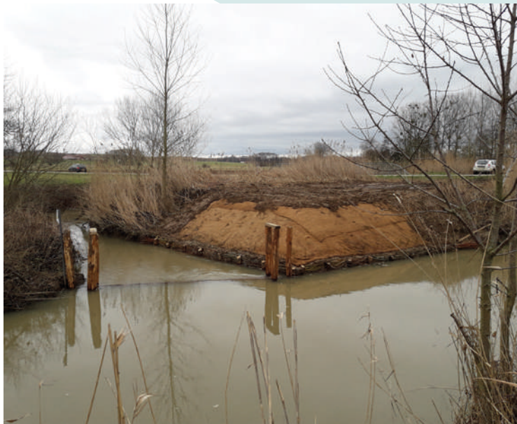
L'ouvrage de répartition drome
