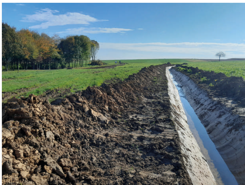
Fossé provisoire de reprise des eaux
