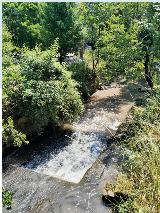
Le gros seuil qui assure la répartition
